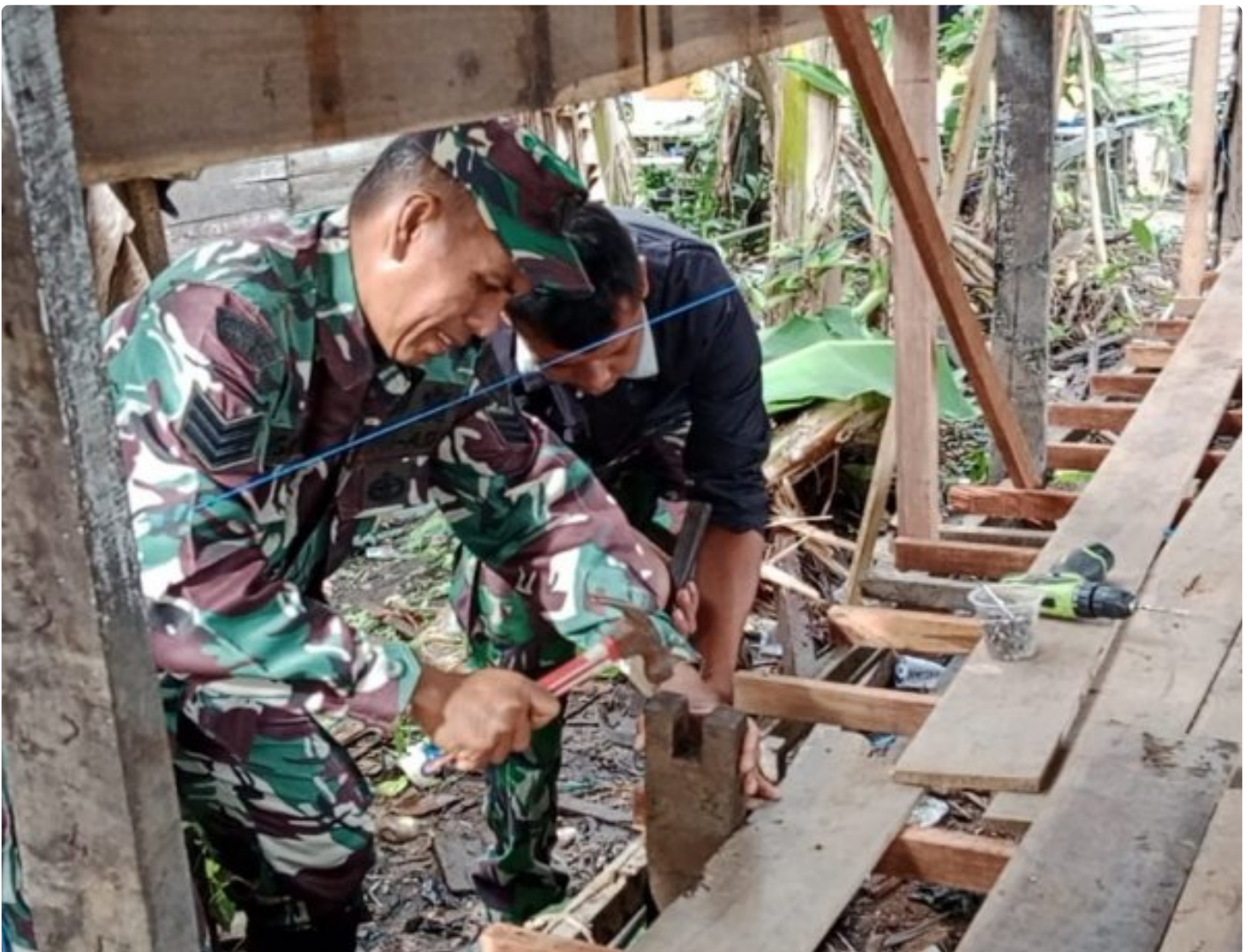
Bongkar Rumah Warga "Danramil Astambul Kini Tahap Pemasangan Lantai Kayu dan Dinding
