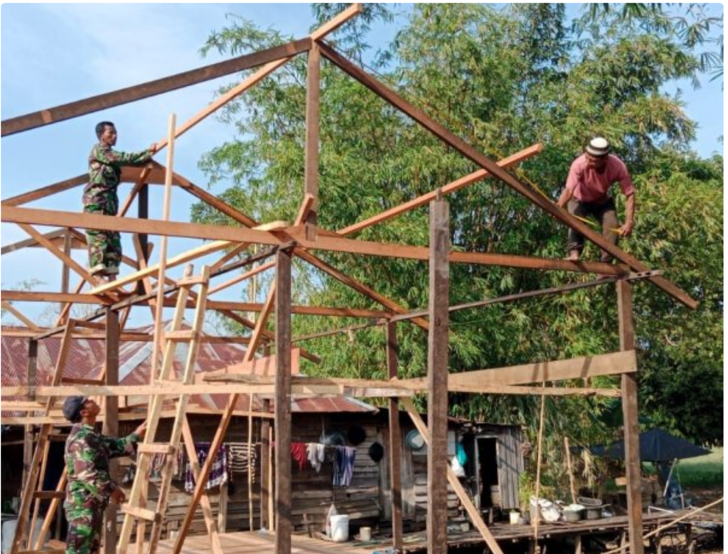
Karya Bakti TNI " Kodim 1006/Bjr Rehab Rumah Kini Sudah Pemasangan Lantai Dan Kuda - Kuda
