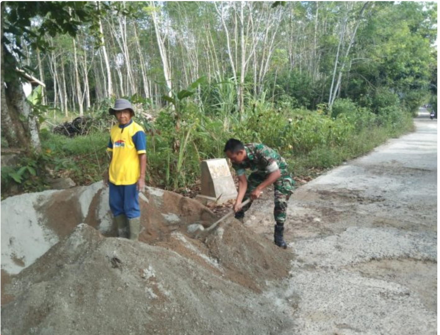
Babinsa Bantu Gotong Royong Pengecoran Jalan
