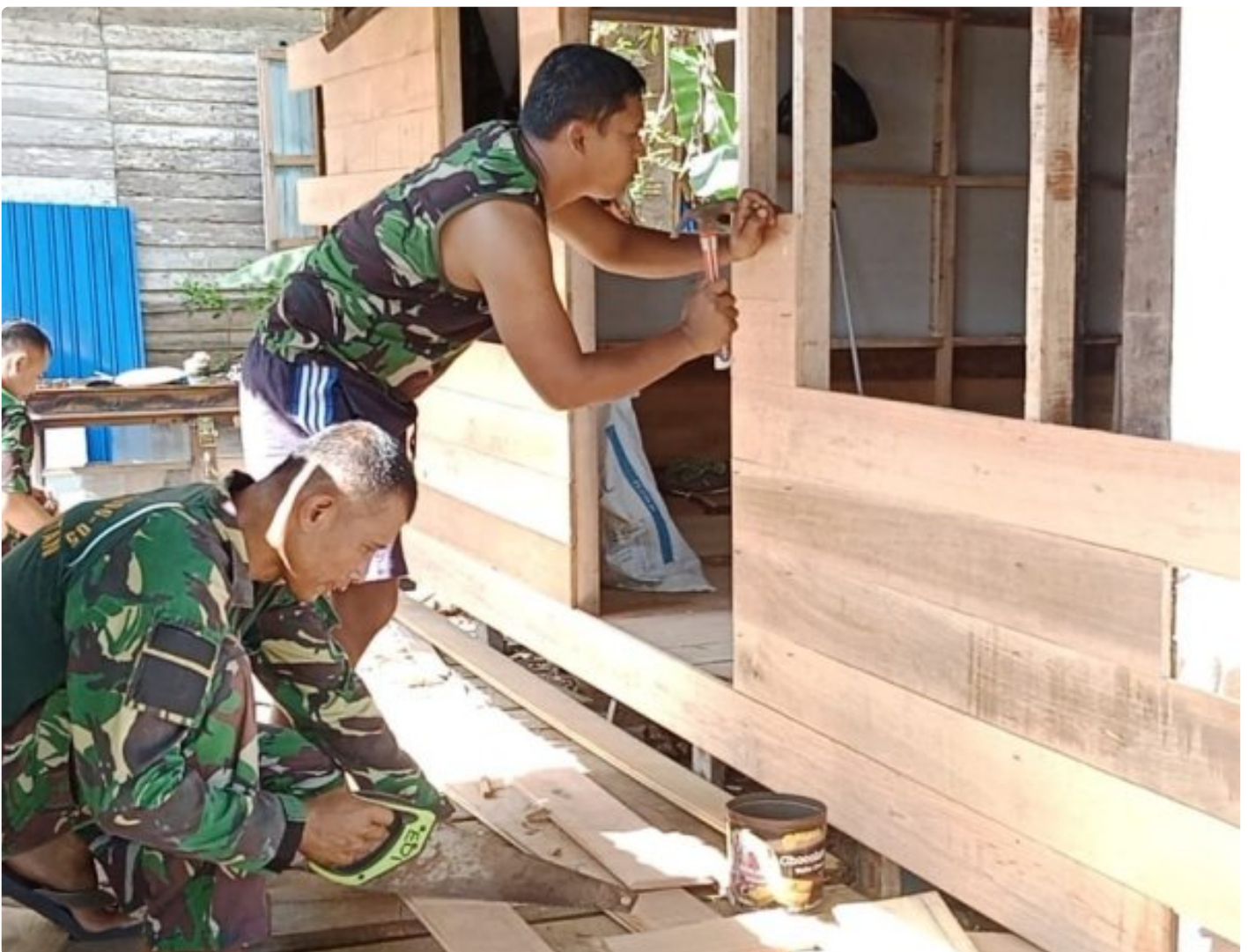
Rehab RTLH Karya Bakti TNI Kodim 1006/Bjr " Hampir Rampung, Pak Walili Tak Sabar Huni Rumah Baru
