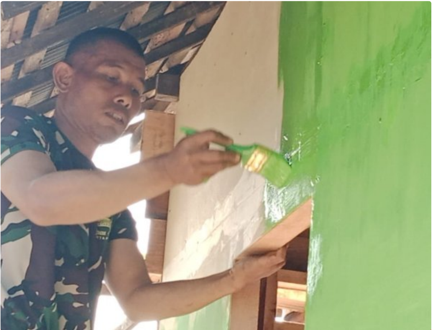
Rehab Rumah Warga Tak Mampu Astambul Masuk Tahap Pengecatan Dan Penyelesaian
