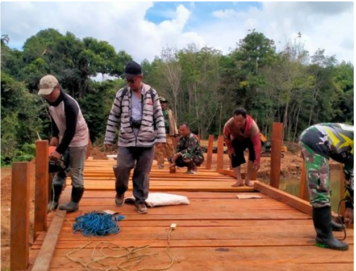
Satgas TMMD Ke-113 Kodim 1006/Banjar Kebut Pengerjaan Jembatan Penghubung
