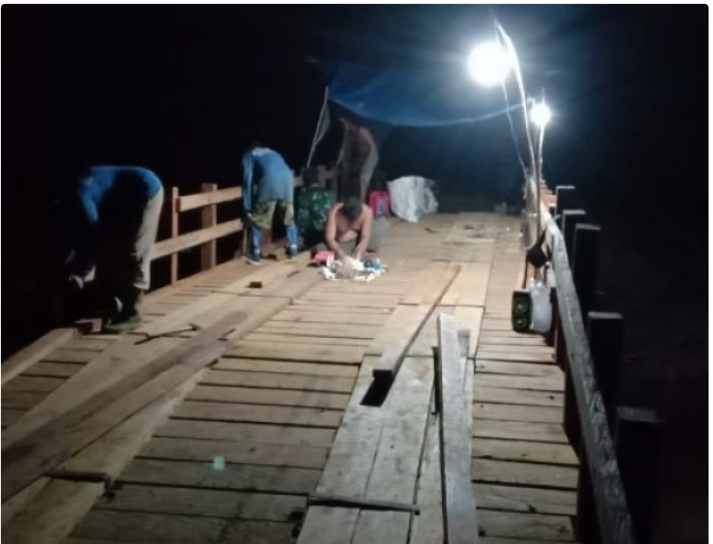
Kerja lembur Satgas TMMD ke-113 Kodim 1006/Banjar Selesaikan Sasaran Jembatan
