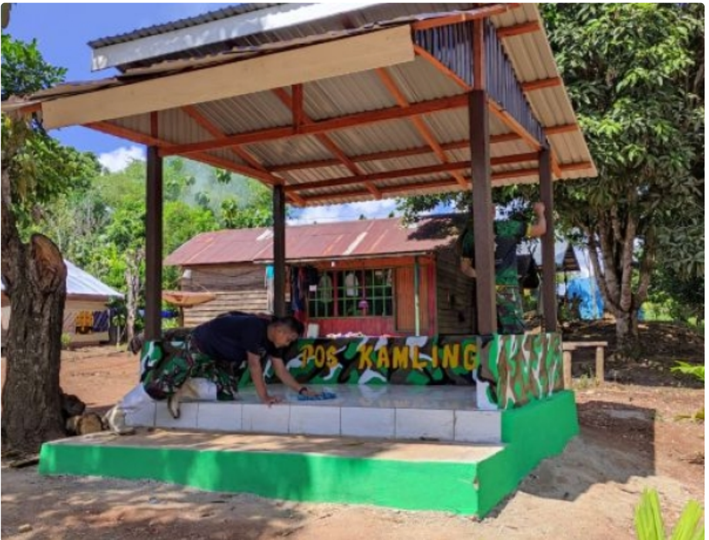
Anggota Satgas TMMD ke-113 Kodim 1006/Banjar Finshing Pembangunan Pos Kamling
